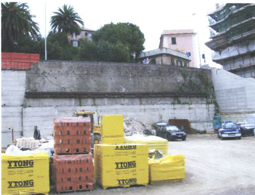
OPERA DI CONSOLIDAMENTO MURO DI SOSTEGNO VIA STURLA ESEGUITA DALLA DITTA "EDILALBARO SRL"
