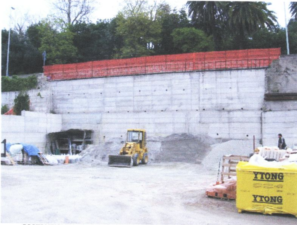
COSTRUZIONE MURO DI SOSTEGNO VIA STURLA PROSPICIENTE LA PROPRIETA' ED ESEGUITA DAL COMUNE DI GENOVA
