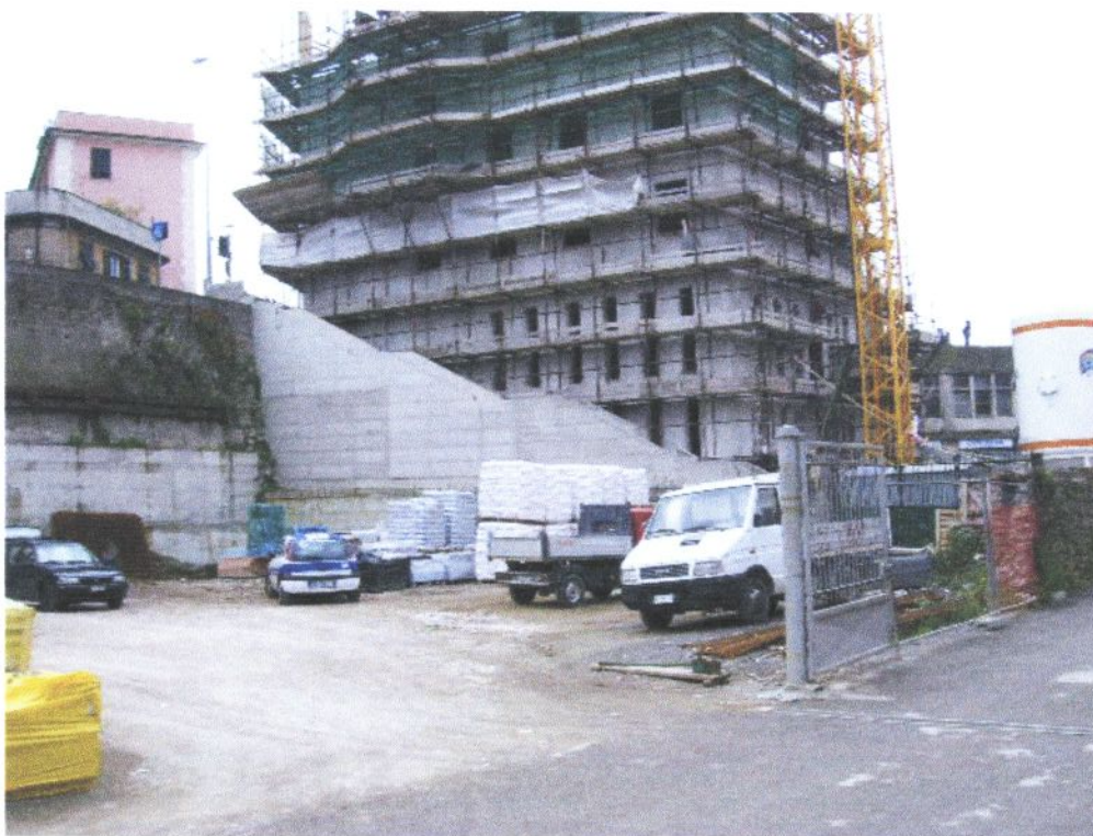
OPERA DI COSTRUZIONE MURO DI SOSTEGNO SCALA COMUNALE ESEGUITA DALLA DITTA "EDILALBARO SRL"
